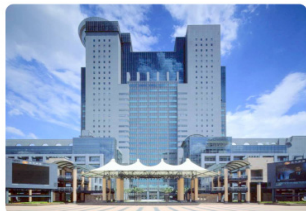
新北市 政府行政大樓 監控系統整合暨能源管理建置
