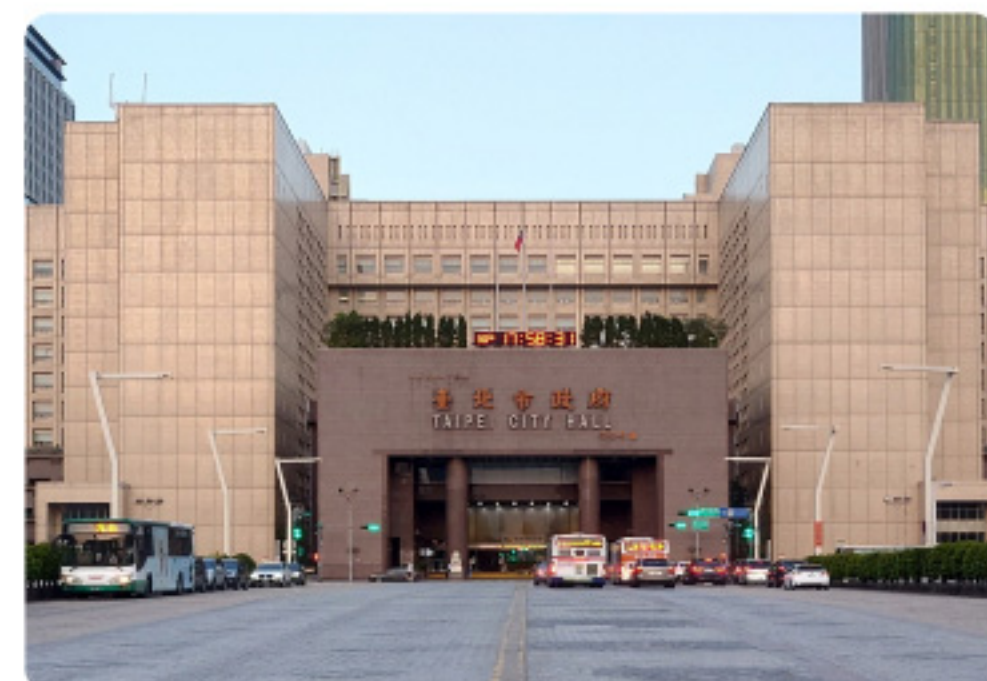
臺北市市政大樓 中控防護系統整合
